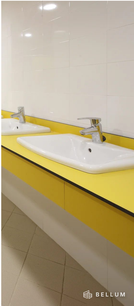
En amarillo, con lavabos encastrados
